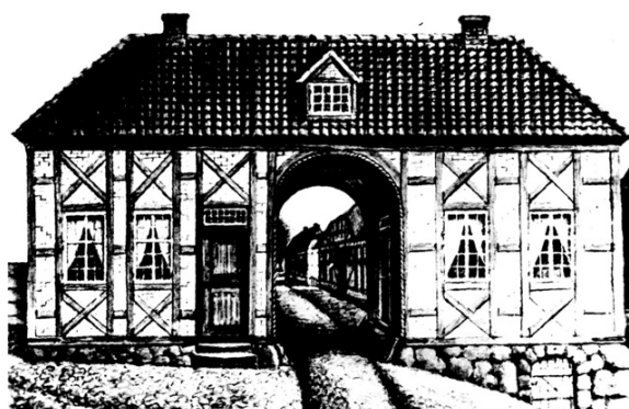
Abbildung 7: Lübsches Tor, Abriss 1854. Quelle: Stadtarchiv Plön
