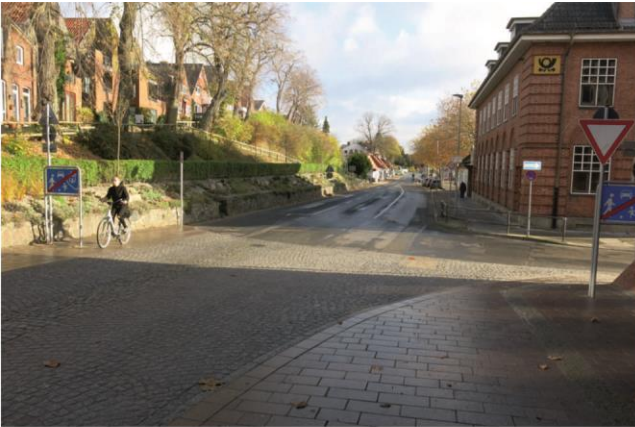
Kfz-orientierte Verkehrsgestaltung: Großzügige Knotenpunkte mit langen Querungswegen sowie fehlenden Überquerungshilfen und Leitmarkierungen
