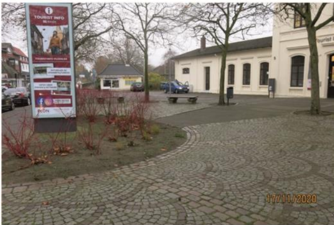
Belagsvielfalt: Nebeneinander diverser Belagsformen beeinträchtigt die Freiraumqualität und die Barrierefreiheit
