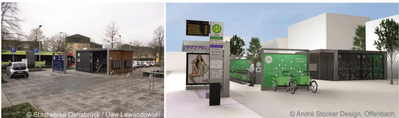
Bild 6-8: Mobilitätsstationen in Osnabrück (links realisiert, rechts Designkonzept)
