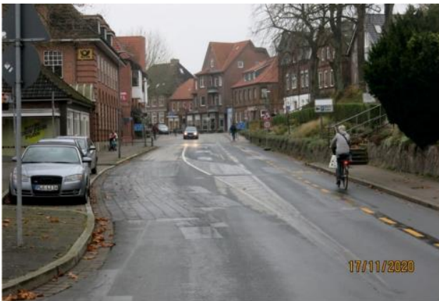
Bahnhofstraße: Nahezu unveränderter Straßenraum der alten B76 entspricht nicht der heutigen Verkehrssituation
