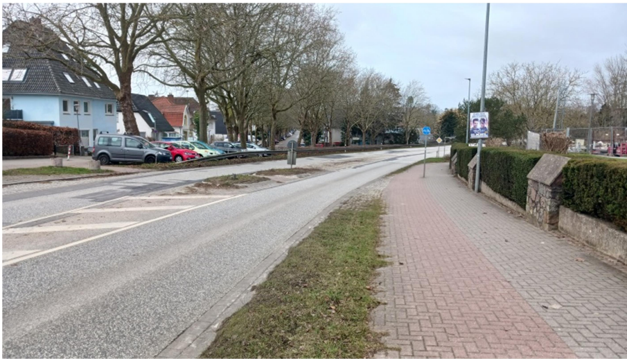
Einfahrt I in Eutiner Straße mittels Querungshilfe/Mittelinsel über B 76
