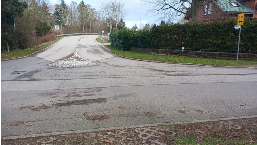
Einmündung Ihlpool (einzige Kfz Zu- und Ausfahrt) in Eutiner Straße mit Rechts vor Links in Tempo 30 Zone
