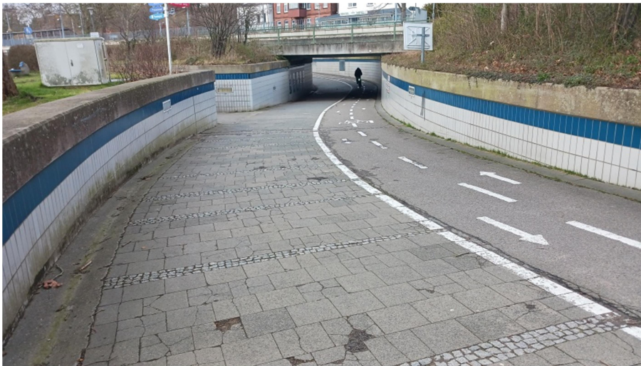
Bahnunterführung mit Querschnitt 3,5 m Fußweg und 2 x 1 m engen Radweg
